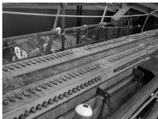
写真-11 鋼アーチ橋補強
