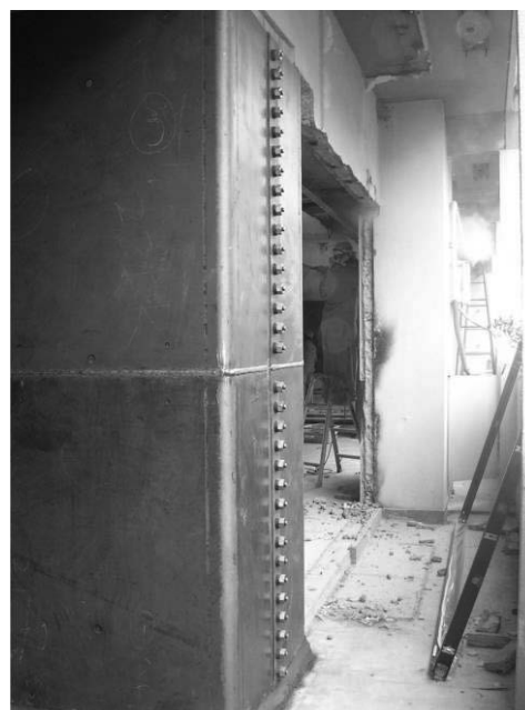
写真-10 RC柱鋼板巻き補強
