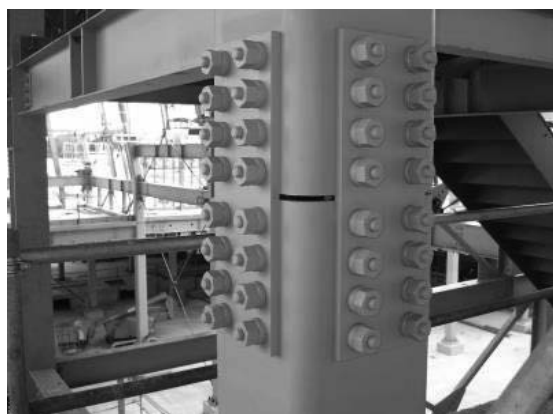
写真-9 角形鋼管柱継手
