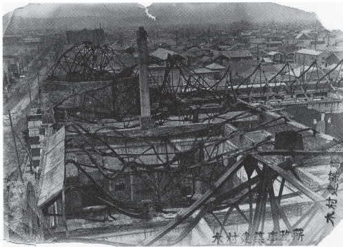
fig. 42 震災後の開港記念横浜会館被災状況 屋根部写真 〔横浜都市発展記念館所蔵〕
