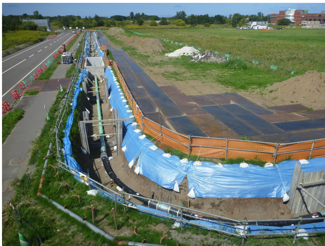
石狩プロジェクトの 500 m 敷設状況の写真、HP より。筑本中部大学教授提供
