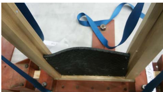
写真 3 ブラパネルの面外方向の変形（真壁中抜き）
