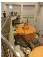
図 8 相模発電所 (神奈川県企業局利水電気部) [交流同期発電機,フランス水車;三菱電機,三菱重工業]
